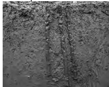
7. 竹杭半さい状況 (杭22~24)
