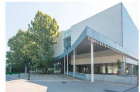
都立多摩図書館(外観)
