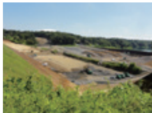
堤体強化工事の様子
