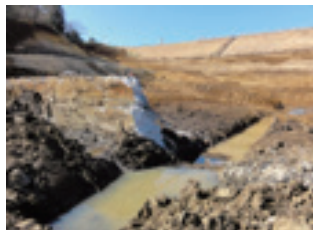
解体中の擁壁
