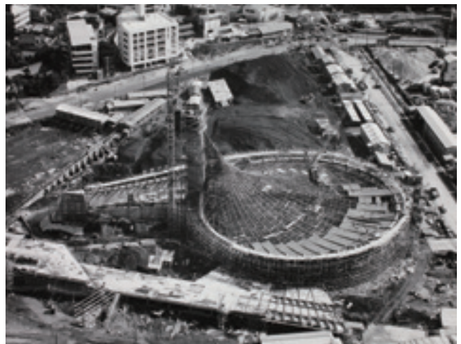
建設中の国立代代木競技場第二体育館 (提供:株式会社大林組)
