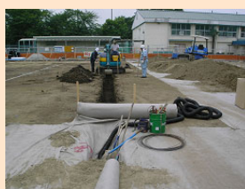
配水管埋設 5月14日
